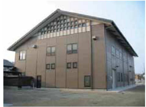
写真1 木質構造試験棟の外観
