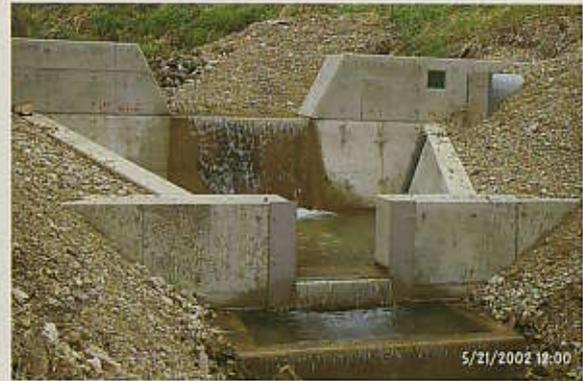
写真1 量水堰（流出量観測施設）
