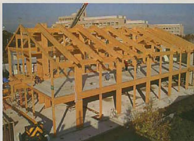
写真2 カラマツ集成材の構造躯体
